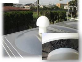
す。すの侵入の恐れがありまより虫等の侵入の恐れがありま通気管の防虫網が破損し破損箇
