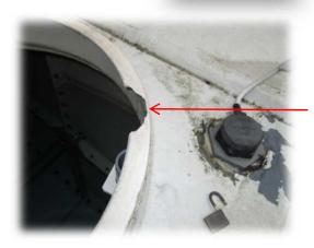
虫等の侵入の恐れがあります。マンホールの枠が欠損し隙間より
